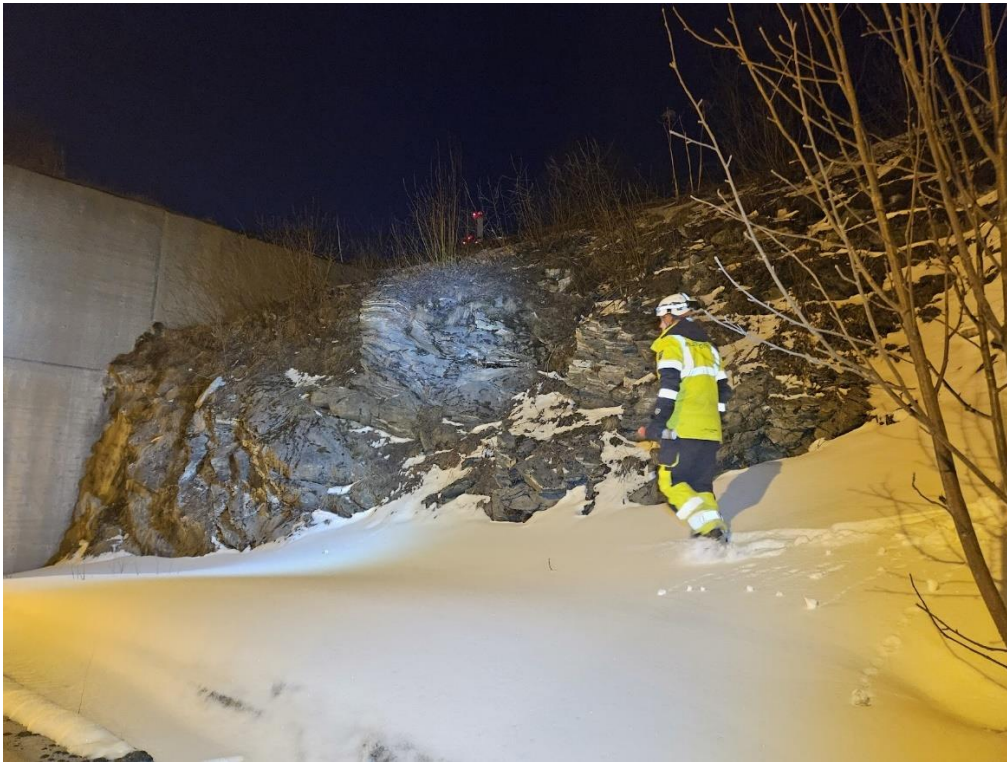
Foto 1. Forskjæring T1, Breivika. Tett oppsprukket og småfallent berg. Mindre løsnestykker vil stoppe i grøfta, til side for vegbanen.
