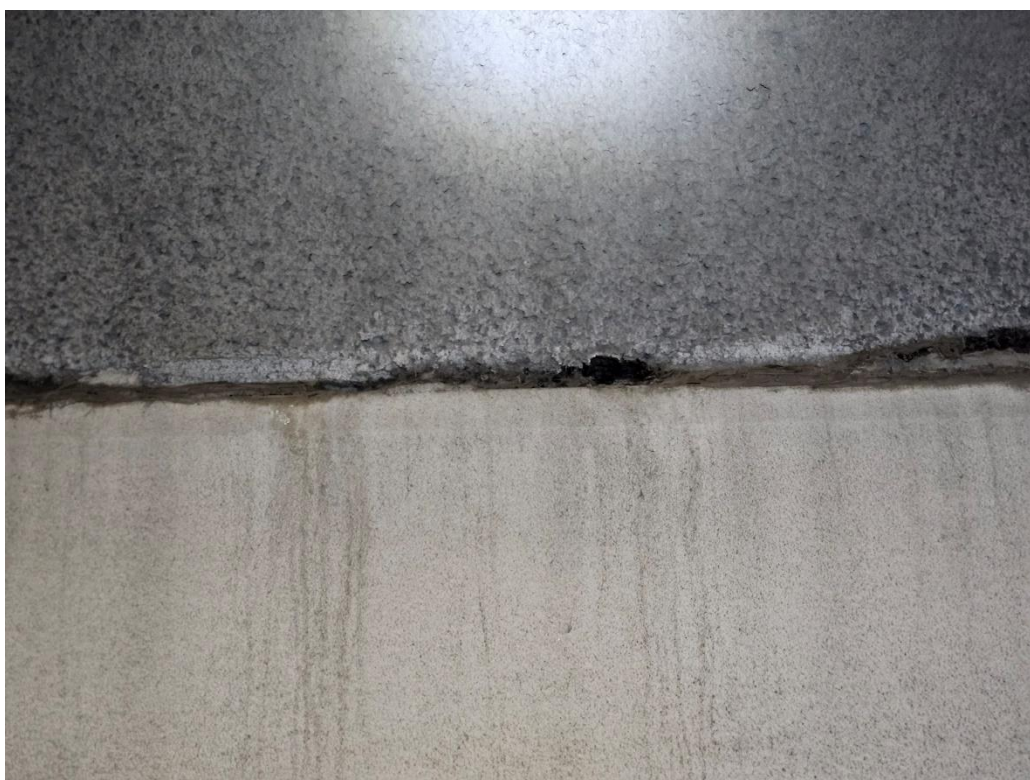
Foto 8. Pel 250, T1. Sprekk i fuge mellom element og sprøytebetong. Observert enkelte steder i begge tunnellop.
