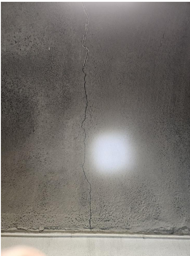
Foto 10. Pel 790, T1. Sprekk i sprøytebetong. Observert enkelte steder i begge tunnellop.
