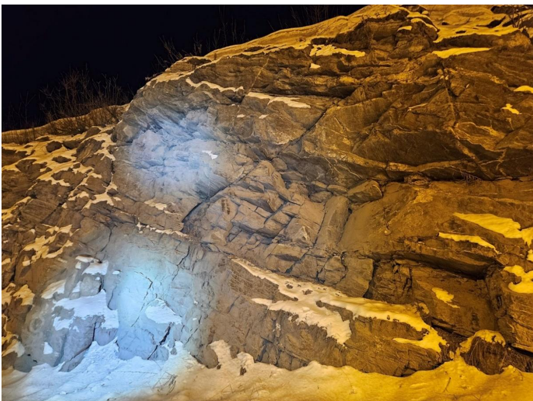
Foto 4. Forskjæring T2, Breivika. Sprekkeavløst bergparti midt i bildet anbefales sikret. Se inntegnet sikringsanvisning i Foto 5. Berget er ellers moderat oppsprukket og stedvis småfallent. Mindre løsnestykker vil stoppe i grøfta, til side for vegbanen.
