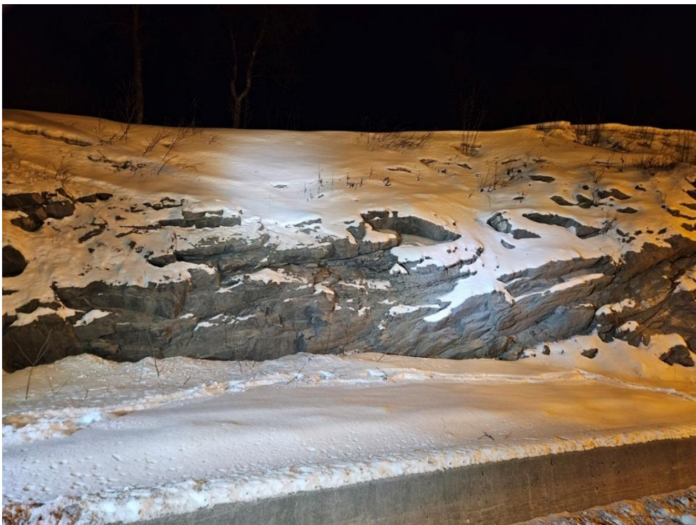
Foto 6. Forskjæring T2, Breivika. Moderat oppsprukket berg. Mindre løsnablokker vil stoppe i grøfta til side for vegbanen.
