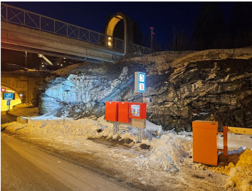
Foto 2. Forskjæring T1, Breivika. Moderat oppsprukket berg. Mindre løsnestykker vil stoppe i grøfta, til side for vegbanen.
