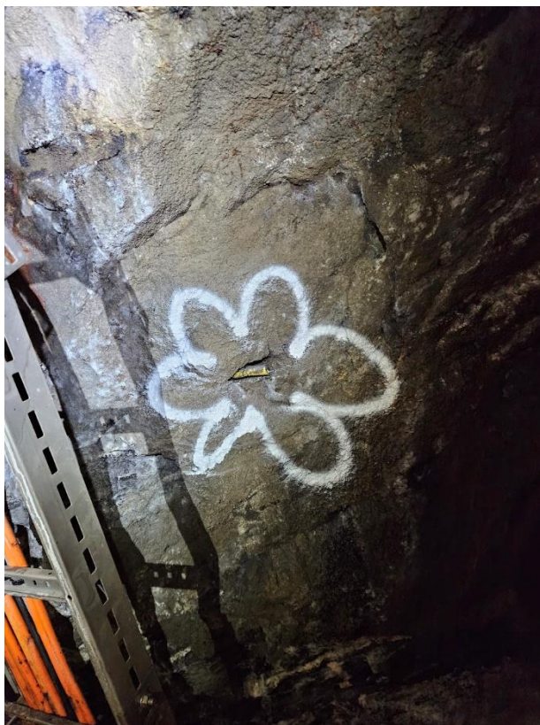
Foto 14. Mulig gjenstående sprenglegeme, tverrsnitt 10.
