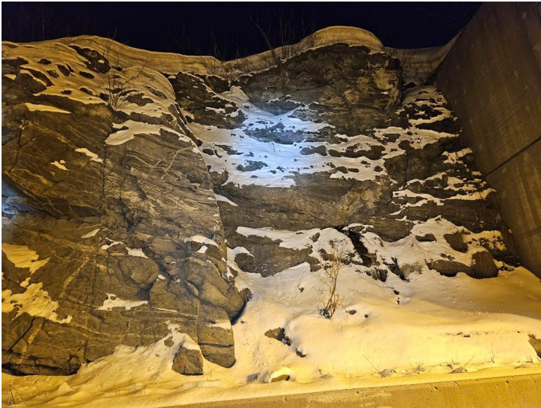
Foto 3. Forskjæring T2, Breivika. Moderat oppsprukket og stedvis småfallent berg. Mindre løsnestykker vil stoppe i grøfta, til side for vegbanen.
