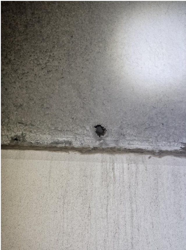
Foto 9. Pel 360, T1. Hull i sprøytebetong, høyre vederlag.
