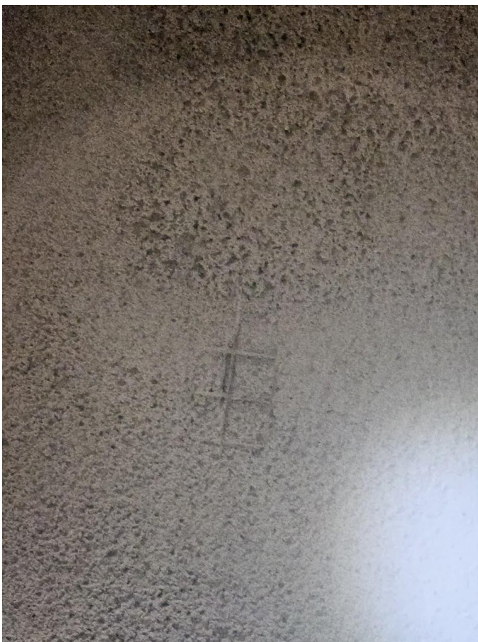
Foto 12. Pel 85, T2. Tynn sprøytebetong, armering er synlig. Observert ved jevne mellomrom i tunnellop T1.
