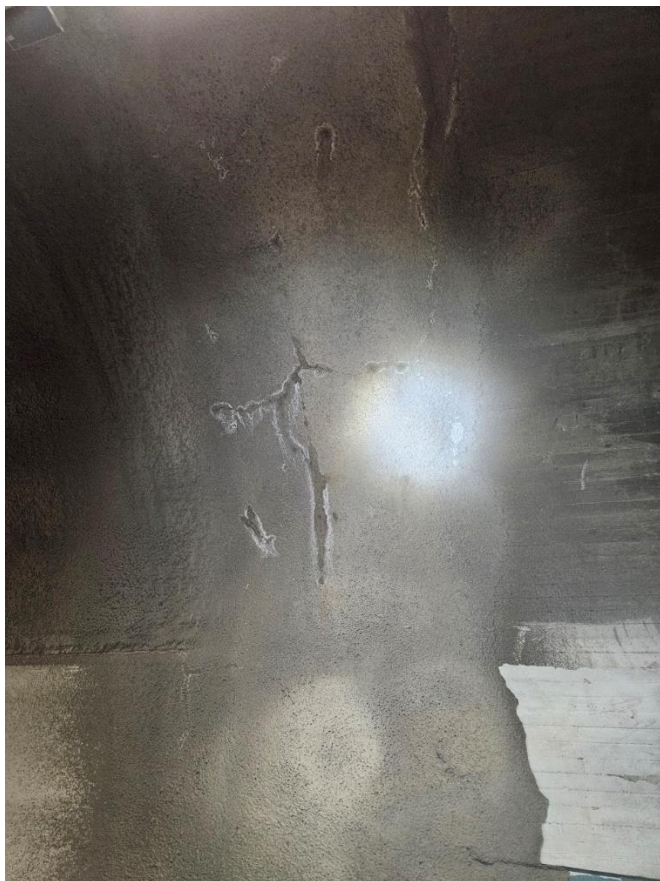
Foto 7. Pel 16, T1. Riss i sprøytebetong med fukt og hvit utfelling. Observert med jevne mellomrom i begge tunnellop.
