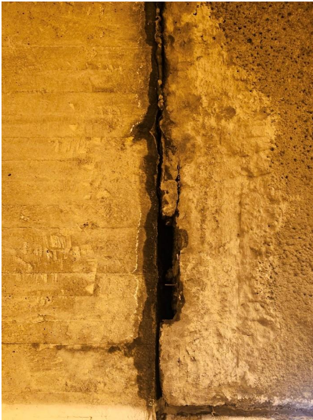
Foto 11. Pel 14, T2. Sprekk i overgang fra betongportal til V/F-sikring.
