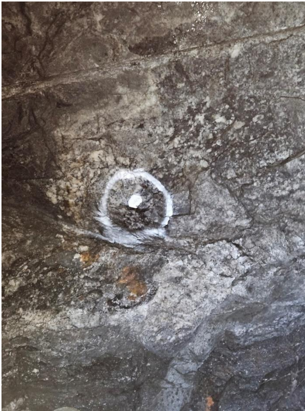
Foto 13. Anvisning av supplerende bombolt, tverrsnitt 6.
